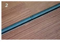
(사진2)처럼 여유분의 타일을 이용해 첫 줄이 일직선인지 확인하여 이음부가 가지런하도록 합니다. 이어지는 다음 줄의 타일 시공을 직선으로 맞추고, 나아가 성공적으로 시공을 마치기 위해 반드시 필요한 작업입니다.
